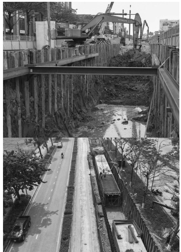
Hình 1.1. Hình ảnh thi công cống hộp ngầm thoát nước chống ngập tại Hà Nội
