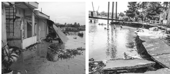
Hình 1. Xói lở bờ sông và bờ hồ tại thành phố Cần Thơ
