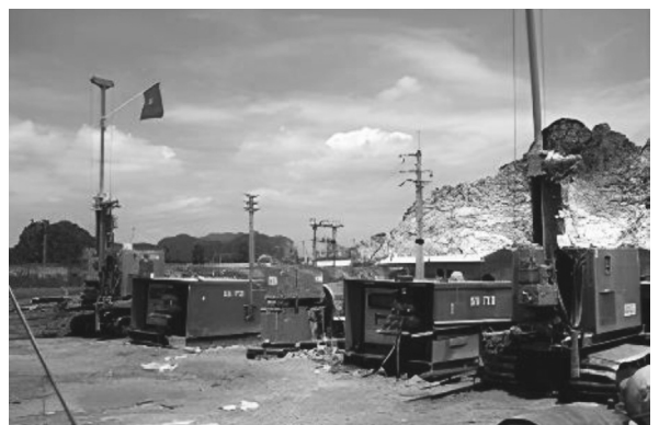
Hình 6. Móng nhà máy xi măng Vinakansai - Ninh Bình (2008)
