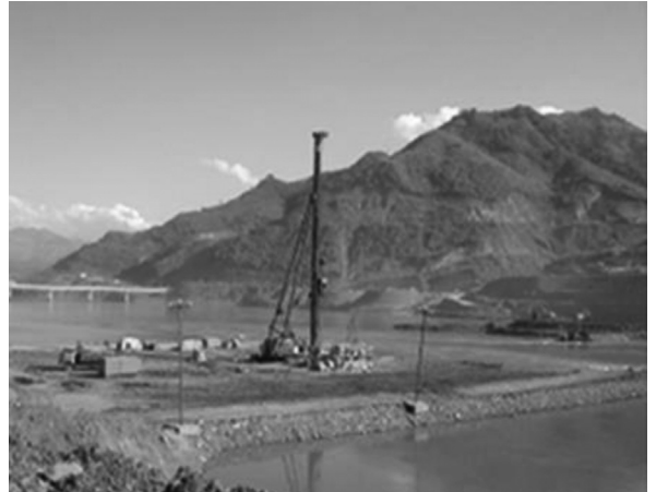
Hình 5. Chống thấm đê quai Thủy điện Sơn La (2005)
