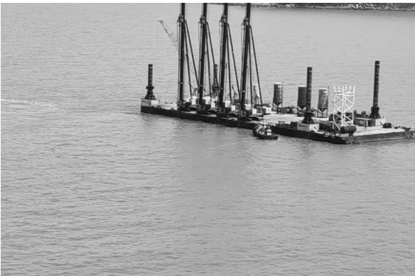
Hình 8. Gia cố móng đê biển ở Cà Mau (2025)
