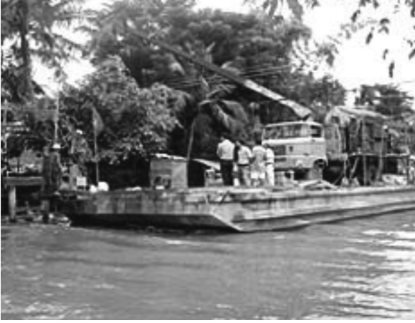
Hình 7. Gia cố móng cống ở Cà Mau (2009)
